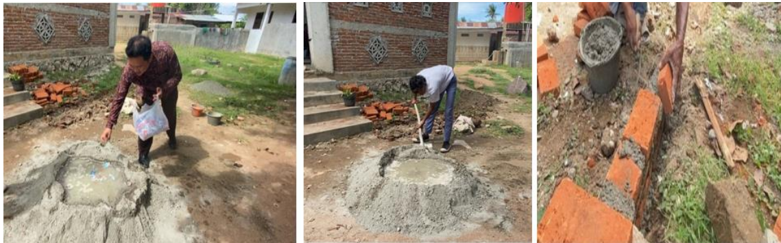
GAMBAR 7. Praktek Pembuatan Beton Limbah
